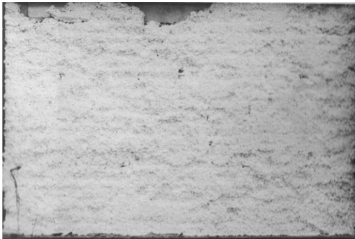
Spouwvulling van gebonden PS-parels zichtbaar na verwijdering buitenblad [17] Injectiepistool voor PS-parels (website VENIN)
