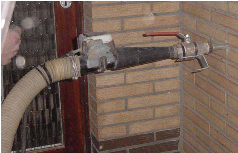
Injectiepistool voor wolvlakken [37]
