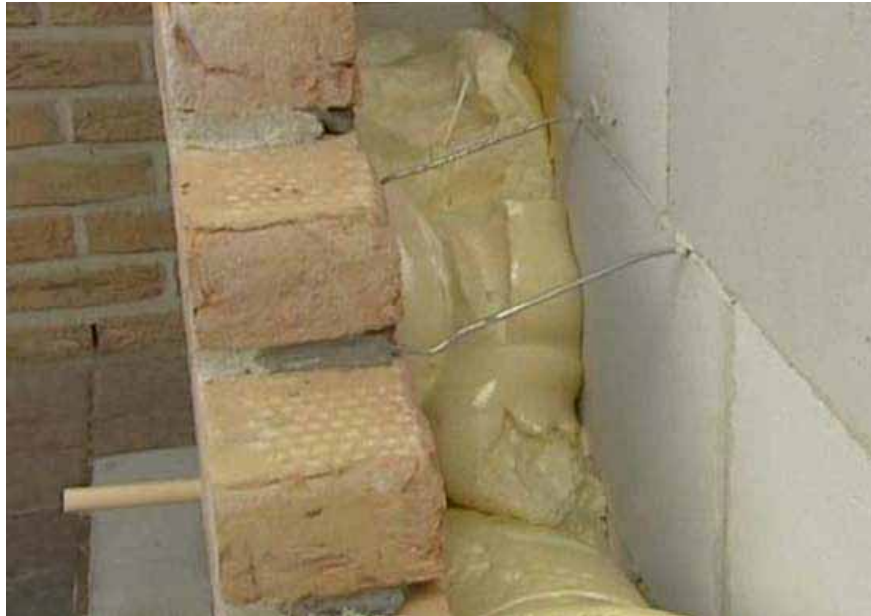
Expanderend PUR-schuim in demonstratiewand (foto Plumiers Isolatie B.V.)
