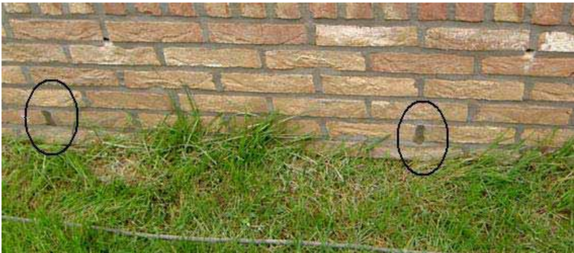
Dichting van drainage-openingen bij vulling met PUR-schuim.
