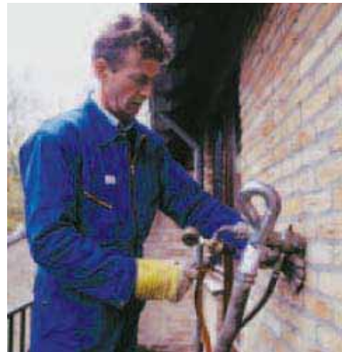
Spouwvulling van gebonden PS-parels zichtbaar na verwijdering buitenblad [17] Injectiepistool voor PS-parels (website VENIN)
