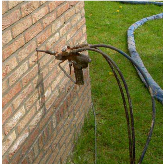
Injecteerpistool waarin de drie componenten samen komen
