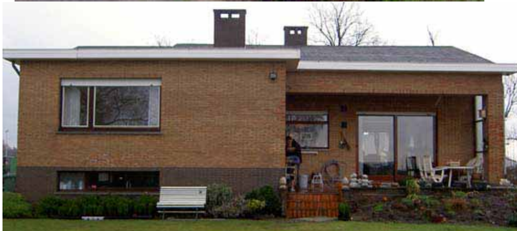
Voor- en achtergevel van woning te Stabroek
